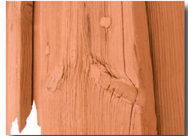
Asikkalan kellotapulin alaosan pystylauta. Laudan koko on 11/2" x 10 1/2" eli paksuus 38 mm ja leveys 265 mm.
